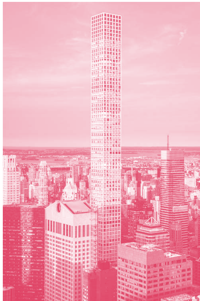
Fotografia do edifício 432 Park Avenue do arquitecto Rafael Viñoly, Nova Iorque © dconvertini, CC-BY-SA-2.0
